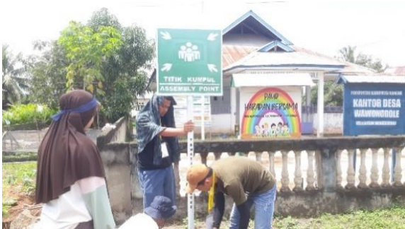
Gambar 5. Pemasangan plang titik kumpul depan Kantor Desa desa Wawangole
