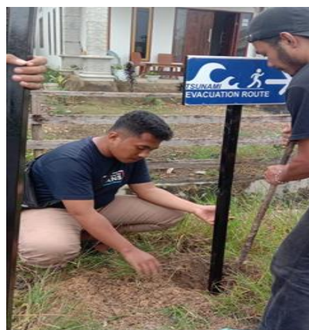
Gambar 11. Pemasangan jalur evakuasi ke arah titik kumpul.
